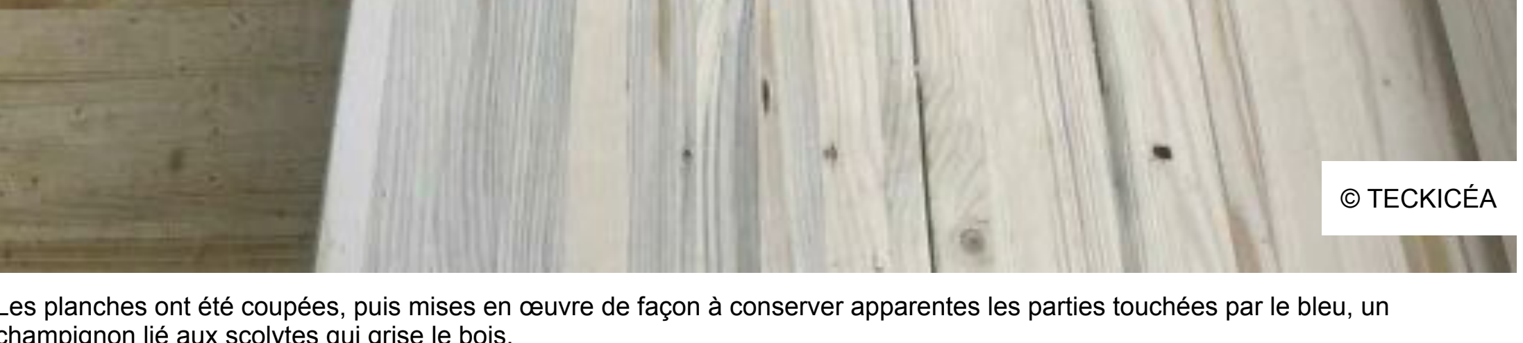
Les planches ont été coupées, puis mises en œuvre de façon à conserver apparentes les parties touchées par le bleu, un champignon lié aux scolytes qui grise le bois.
